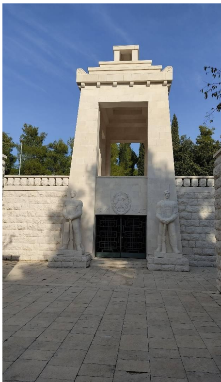
Južni pogled- mauzolejski prostor
