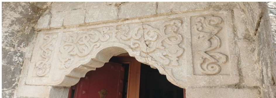
Oštećenje ulaznog kamenog portala
